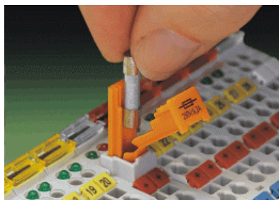
Abb. 2-17: Sicherung wechseln
